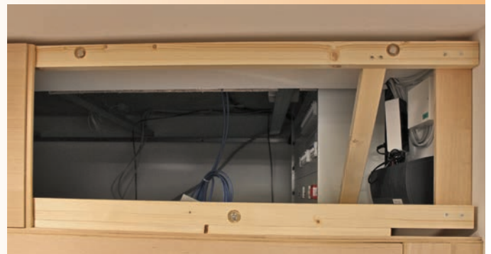
Detail: Revisionsklappe oberhalb der Sauna mit Magneten als Punkthalter.
