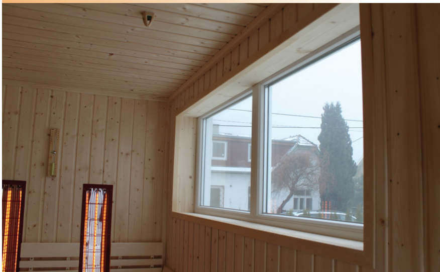
Detail: Fensterlaibung mit Fichtepaneelen („Fenster vorgezogen“)
