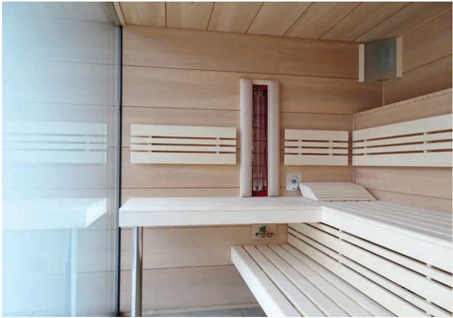
Detail: Sauna wurde an ein großes, bestehendes Fenster angearbeitet
