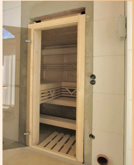
Tür vorgezogen mit Abluftkanal nach vorne
